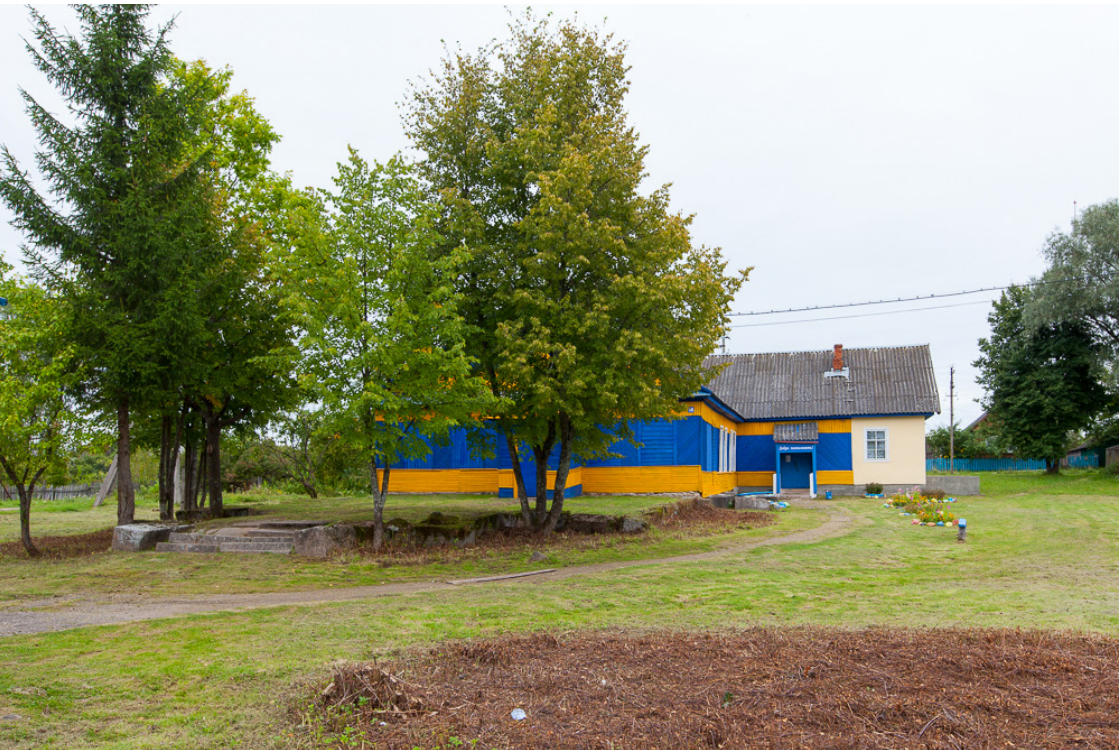
Фундамент Залучской церкви, фото 2017 года
