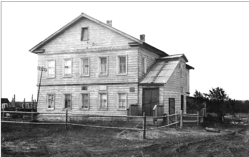
Причтовый дом, построенный в 1886 году. Фото из фондов Колвинского краеведческого музея.
