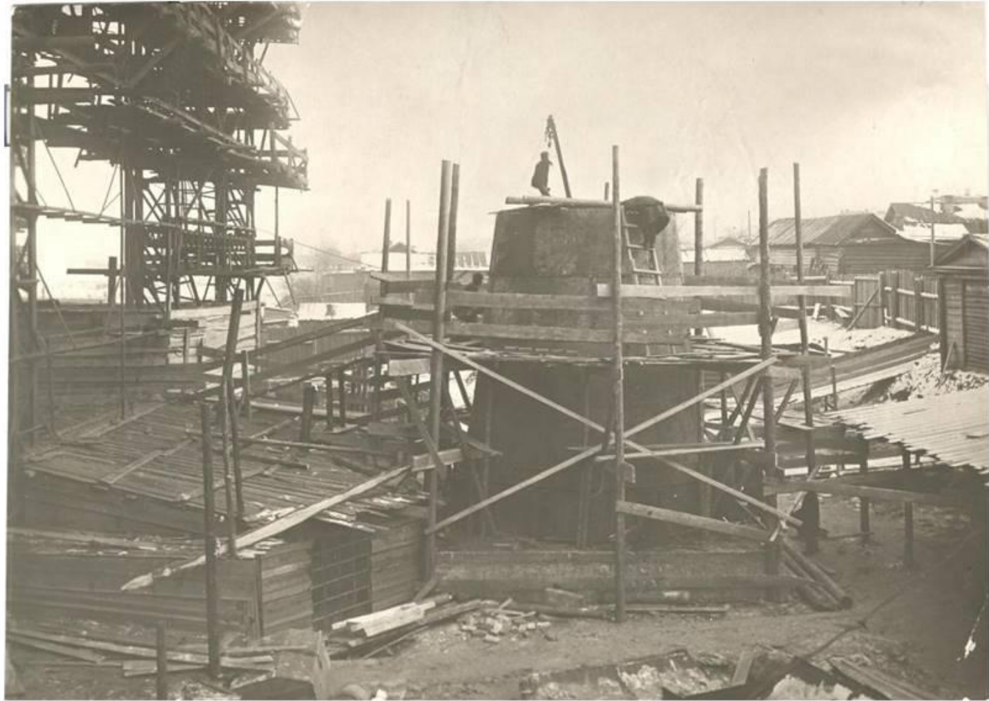
Строительство мартеновской печи № 2. 1928 г.
