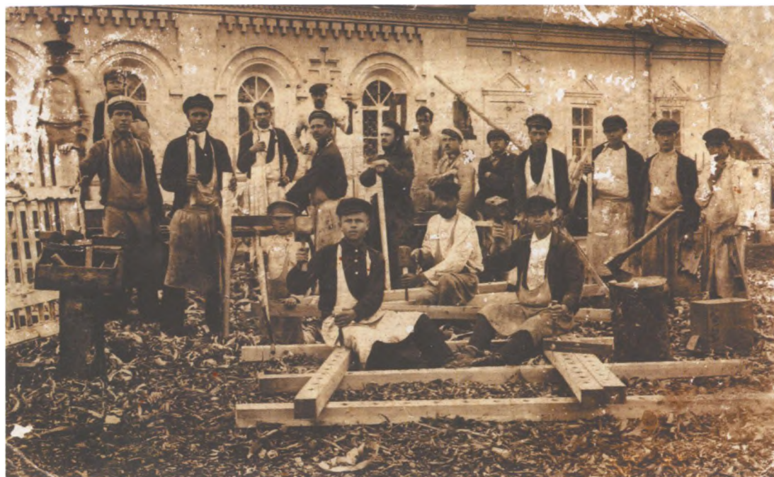
Священник Архангельский Александр Елпидифорович на ремонте церковного здания села Большой Кувай Алатырского уезда. 1926 год.
