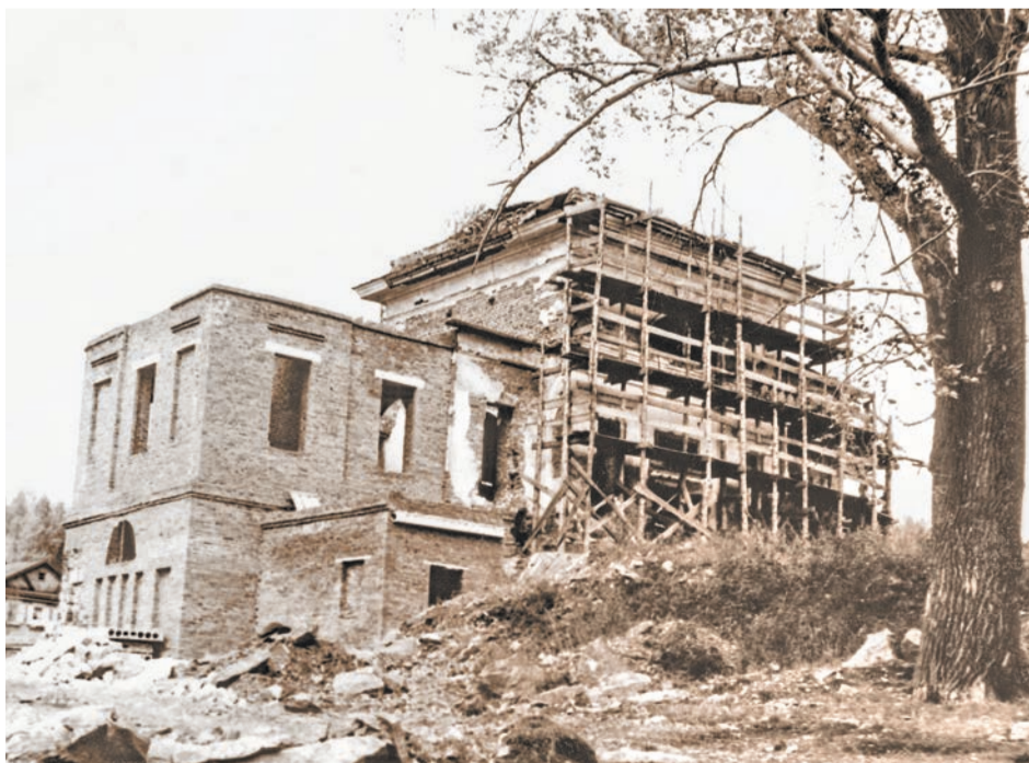
Возрождение храма. Идут строительные работы. Фото 1991 года
