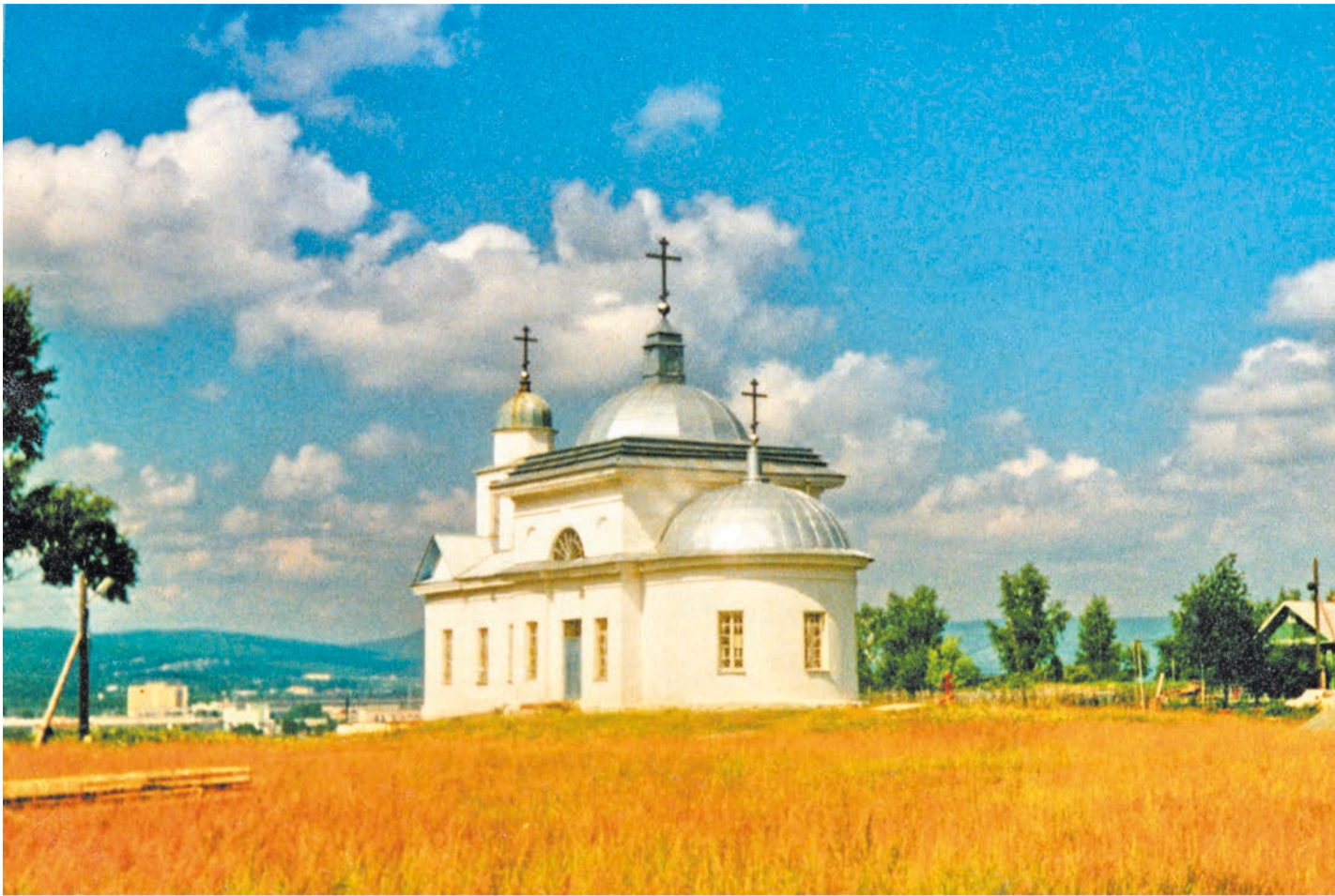
Воскресенский храм после многолетней реконструкции и восстановительных работ. Фото 2001 года
