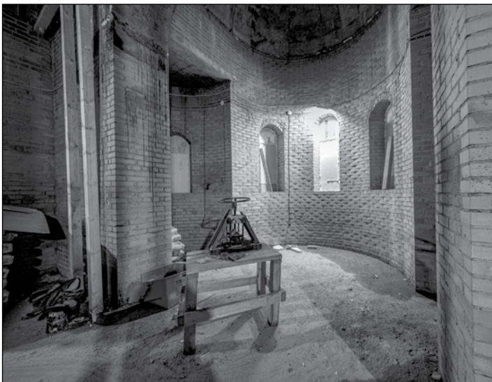
Алтарная часть. Общий вид храма после подъёма купола. 28 декабря 2024 г. Фото П. Д. Земляных.
