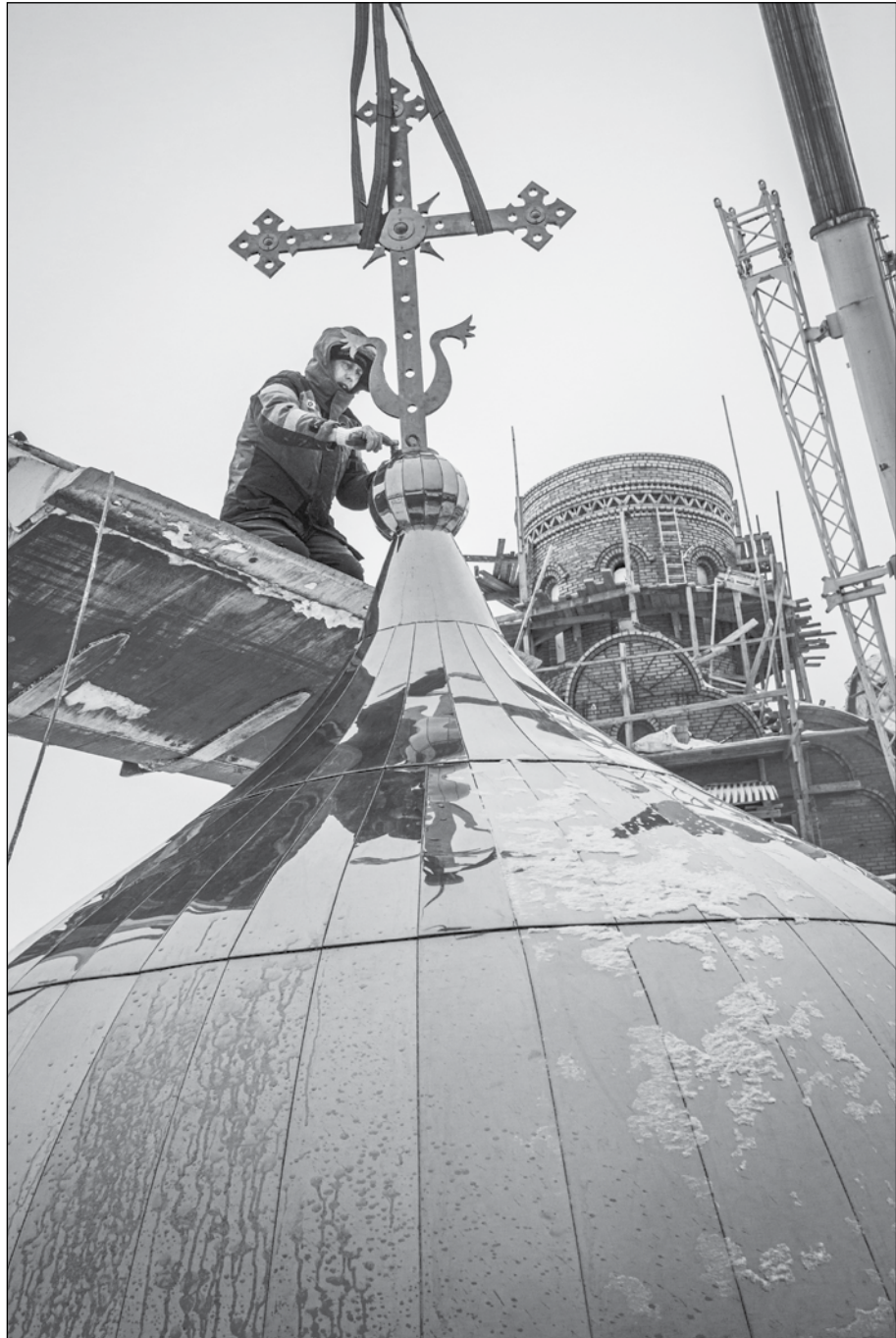
Монтаж креста на куполе храма после освящения. 28 декабря 2024 г. Фото автора.
