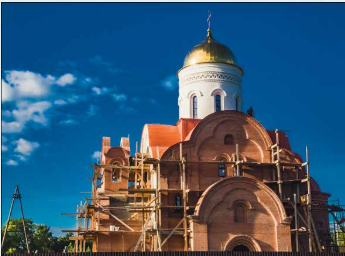
Идут монтаж кровли и покраска храма. 8 июля 2024 г. Фото автора.
