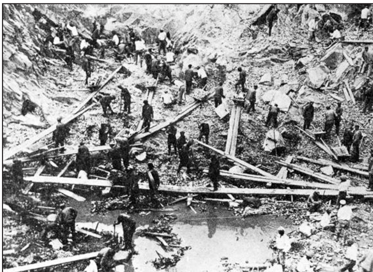
Строительство 11-го шлоза ББК. Из архива А. Мельник
