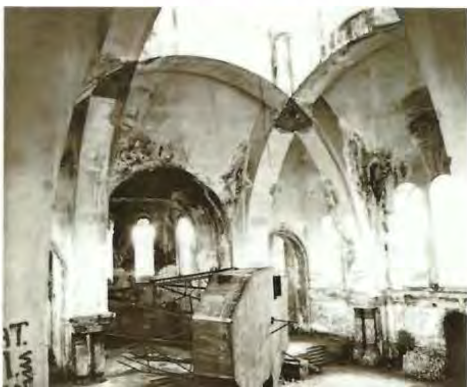
Демонтаж водонапорной башни в алтаре собора
