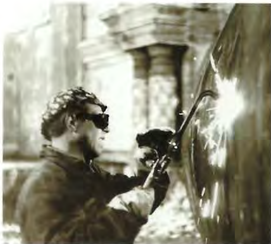
Демонтаж водонапорной башни в алтаре собора
