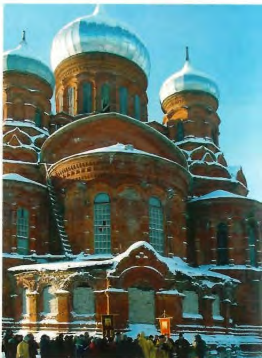
Установка первого креста
