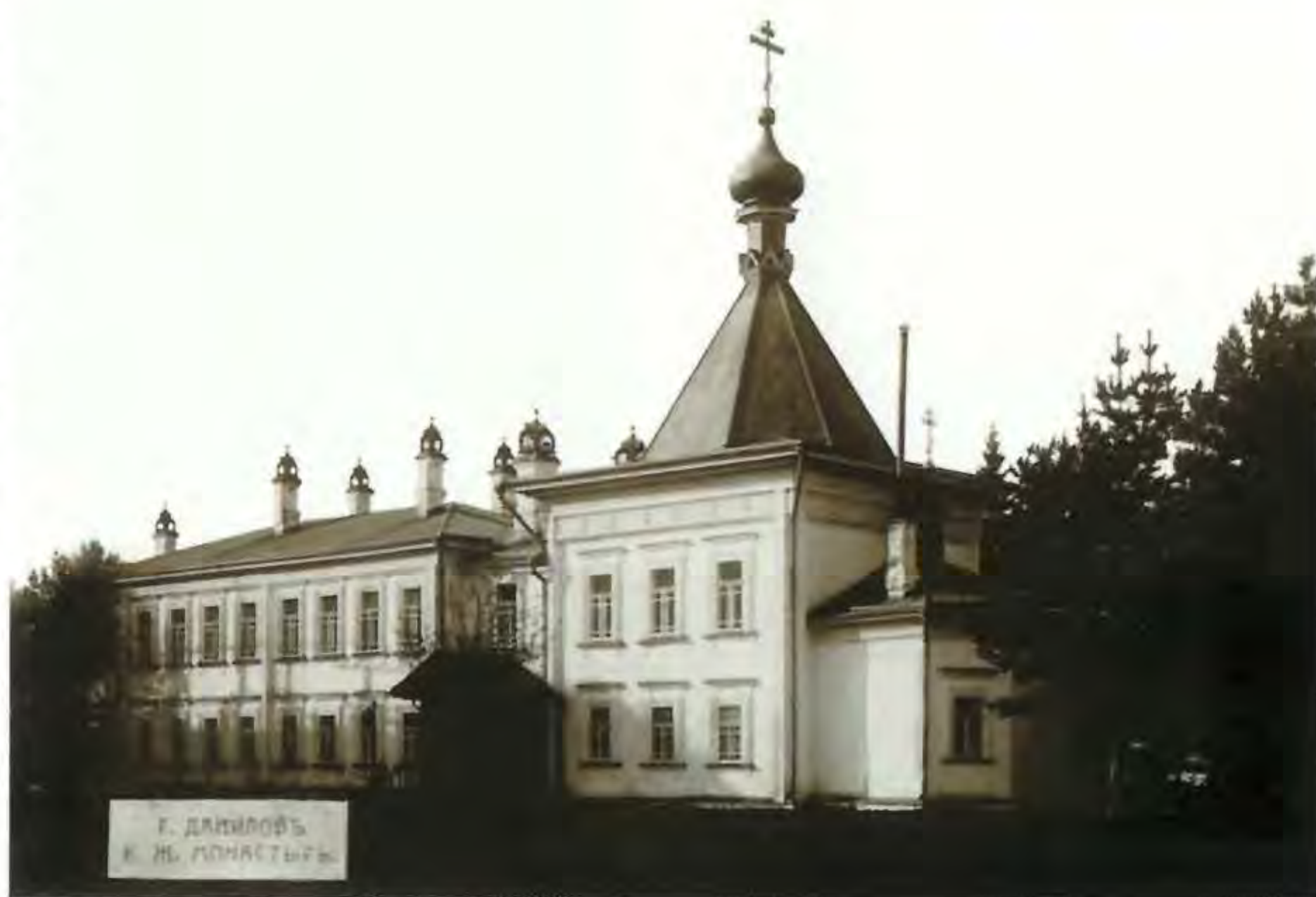
Церковь общины во имя Казанской иконы Божией Матери в одном здании с общежительным корпусом
