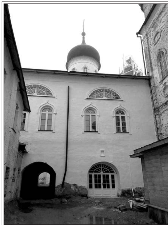
Рис. 1. Вход в северный подклет Свято-Троицкого Зосимо-Савватиевского собора
