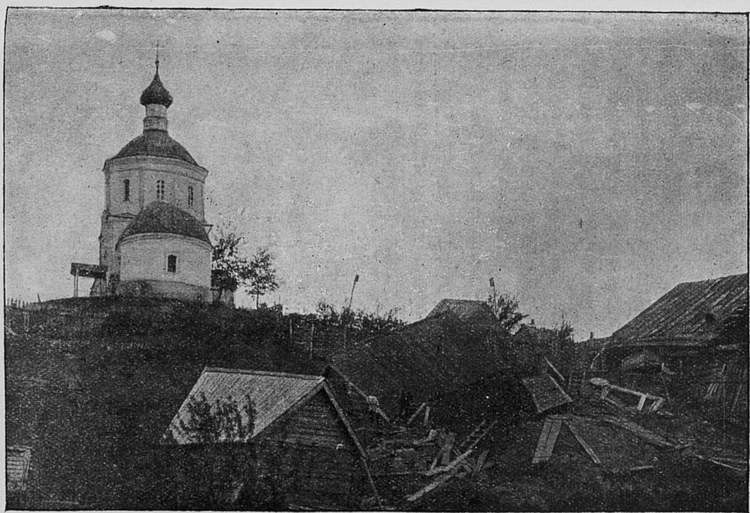
СМОЛЕНСКАЯ ЦЕРКОВЬ Г. СИМБИРСКА ПОСЛѢ ОПОЛЗНЯ СИМБИРСКОЙ ГОРЫ.
