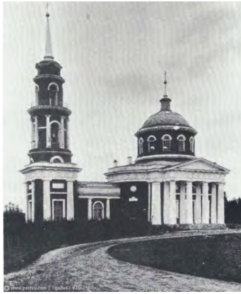
Церковь Иконы Божией Матери Ахтырская.
