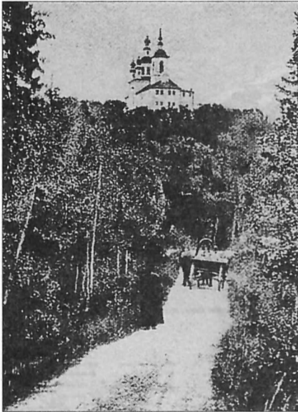
Дорога в Голгофо-Распятский скит
