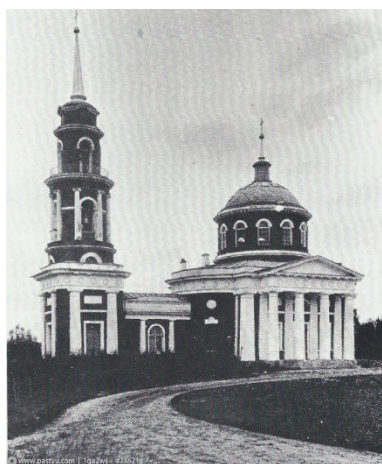
5 Церковь Иконы Божией Матери Ахтырская.
