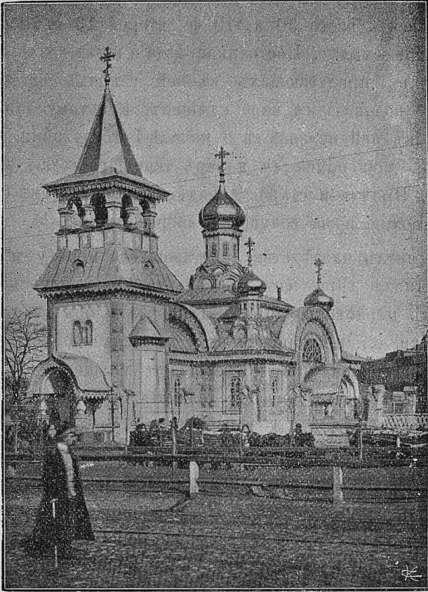
Златоустовская церковь въ 1901 (послѣ ремонта).
